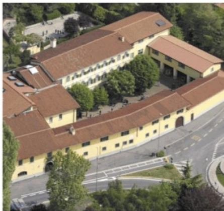
Una bella vista dall'alto della scuola «Cittadini» di Ponte San Pietro
